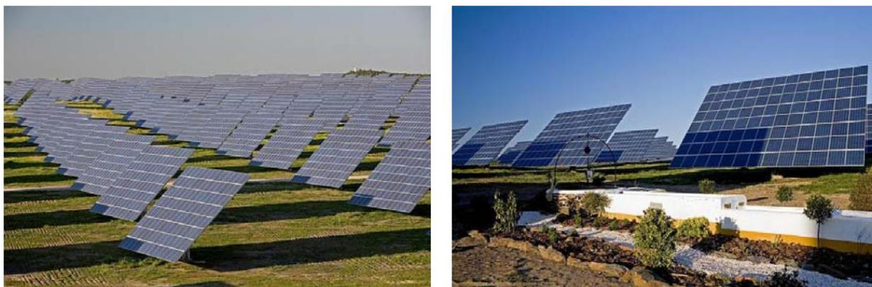
**Fig. 3.34** Configuración de seguidores utilizada en Amareleja y las sombras proyectadas entre unos y otros.
