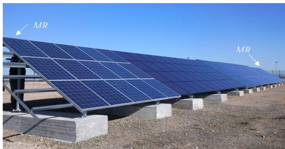
**Fig. 2.8** Zona de experimentación de la central de Tudela compuesta por cinco generadores de cuatro tecnologías diferentes.
