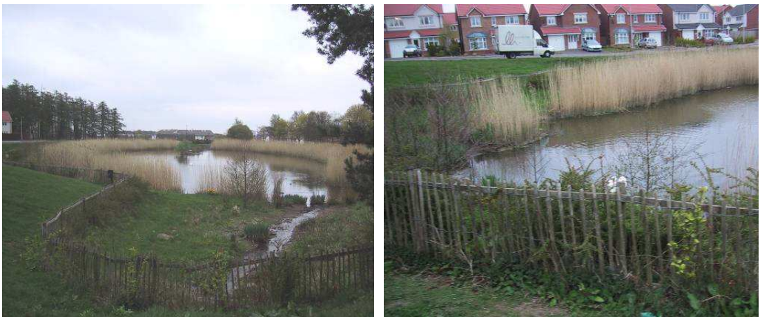
Figura 26 y 27. Estanque de detención.
