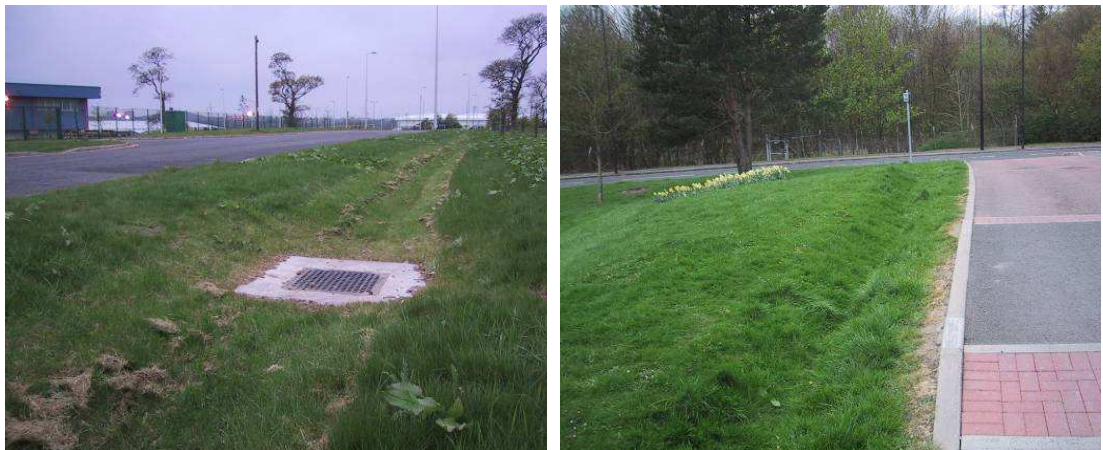
Figura 20 y 21. Cuneta verde como drenaje lateral de calzada.
