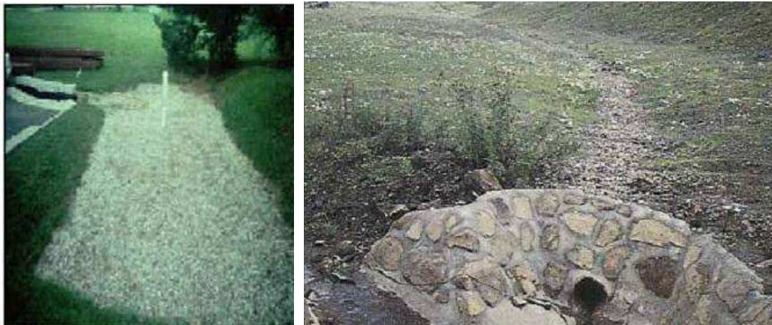
Figura 14 y 15. Pozo y zanja de infiltración con superficie de grava
