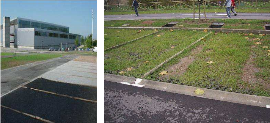
Figura 12 y 13. Firme filtrante con distintos tipos de pavimento
