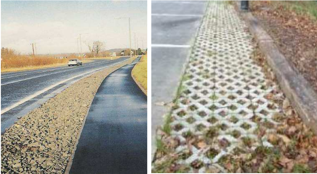
Figura 18 y 19. Dren filtrante como drenaje lateral de calzada
