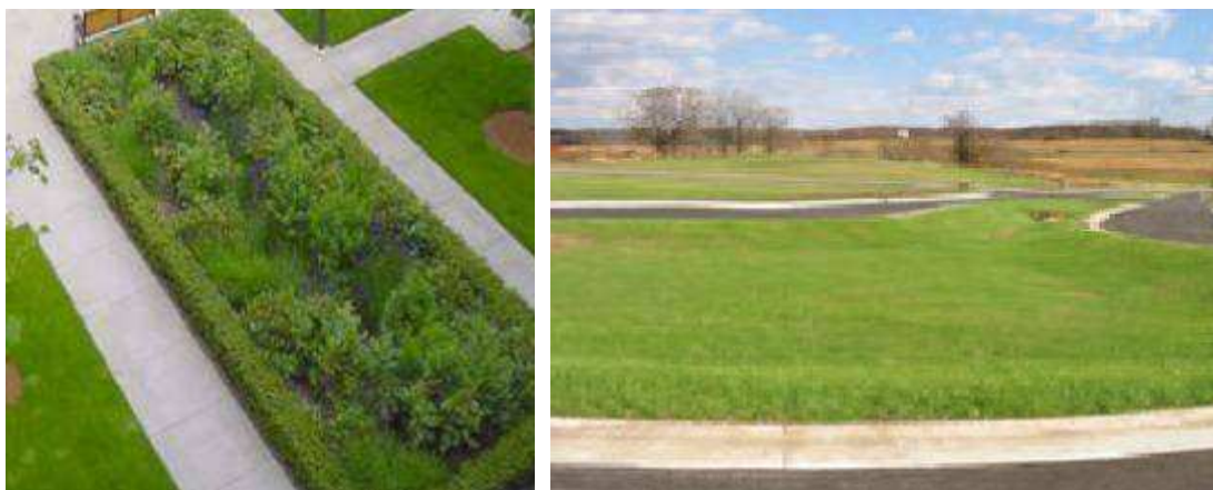
Figura 16 y 17. Depósito de infiltración.
