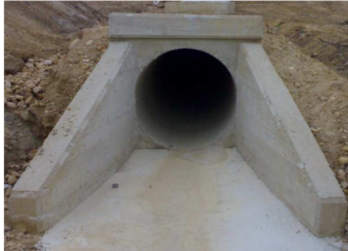
Figura 42. Corchete de hormigón salida rebosadero.
