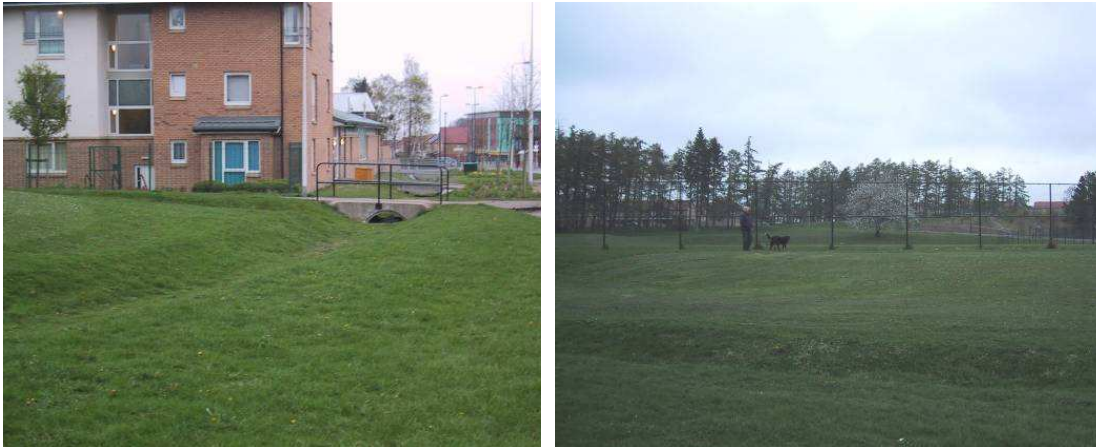
Figura 22 y 23. Franja filtrante conectando con cuneta verde.
