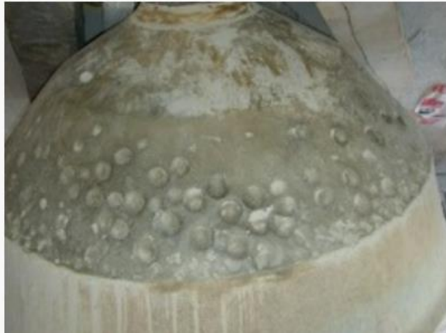
Figura27. Deformaciones de la cámara interior [9]
