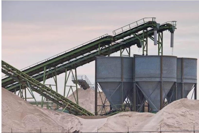
Figura16. Cintas transportadoras de áridos en una cantera
