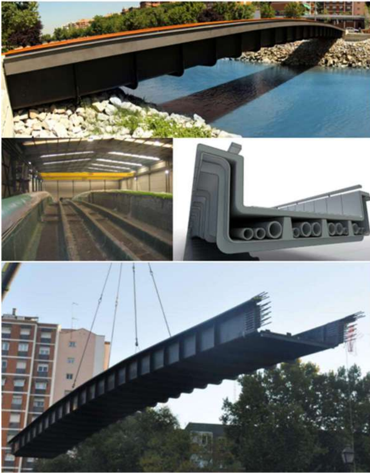
Fig.1.b. Pasarela peatonal en el parque Madrid Río. Aspecto general, detalle de fabricación y detalle de montaje
