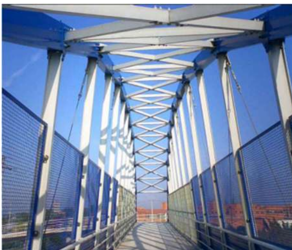
Fig.1.d. Pasarela sobre el AVE en Lérida [8]
