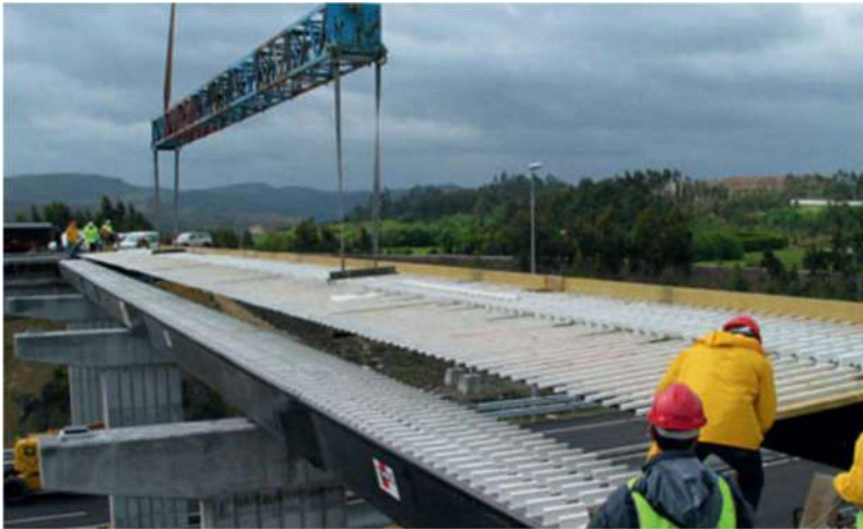
Fig.1.a.1: Montaje general de vigas de PRFV sobre vigas cajón de fibra de carbono, en el paso superior de la autovía del Cantábrico A-8 en Asturias.
