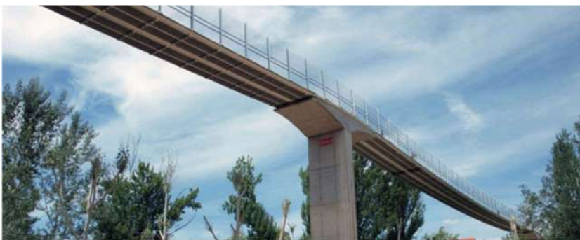
Fig.1.c. Pasarela sobre el río Júcar en Cuenca.
