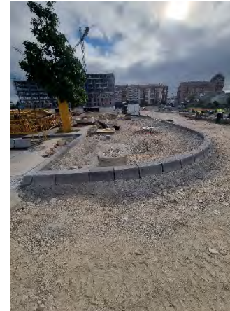
COLOCACIÓN BORDILLO EJE 5
