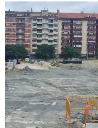
TERRAPLÉN DE SUELO TOLERABLE
