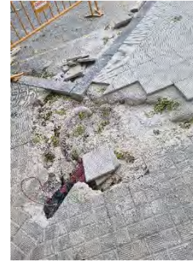
CANALIZACIÓN ALUMBRADO EJE 1
