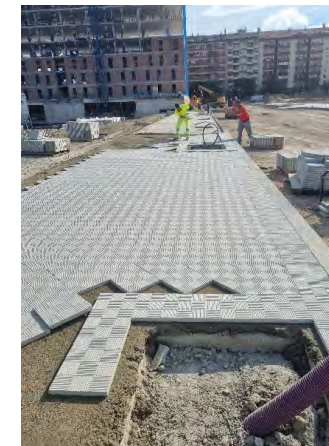
PAVIMENTACIÓN ACERA EJE 5
