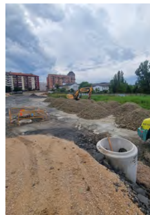
EXCAVACIÓN DE DESMONTE
