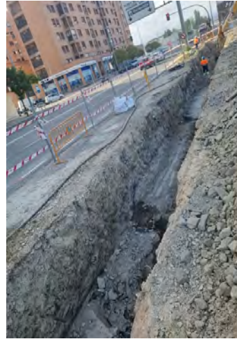
ZANJA REDES SANEAMIENTO
