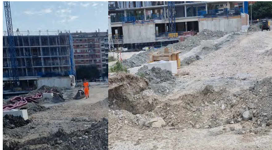
CANALIZACIÓN DE LA DISTRIBUCIÓN ELÉCTRICA
