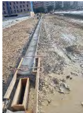
COLOCACIÓN CAZ PREFABRICADO EJE 5
