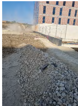
RELLENO EXPLANACIÓN EDIFICACIÓN
