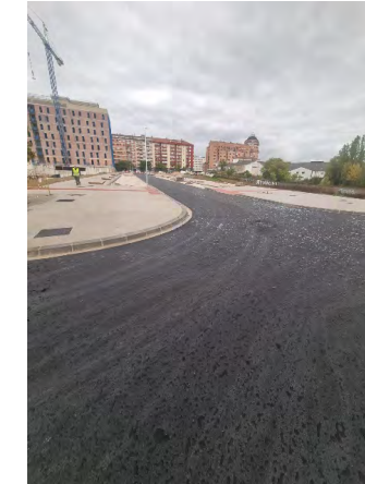
ASFALTADO DE TODOS LOS VIALES
