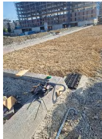
AFIRMADO APARCAMIENTO EJE 5
