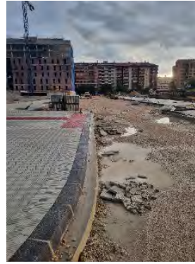
PAVIMENTACIÓN ACERA EJE 1
