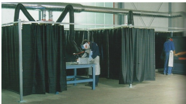
Ilustración 37 Cortinas ignífugas de protección
