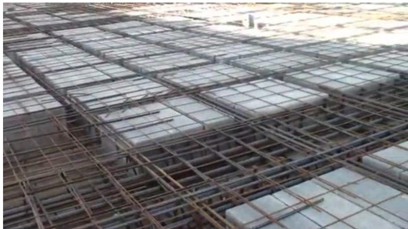
Imagen 4. Armaduras de forjado
