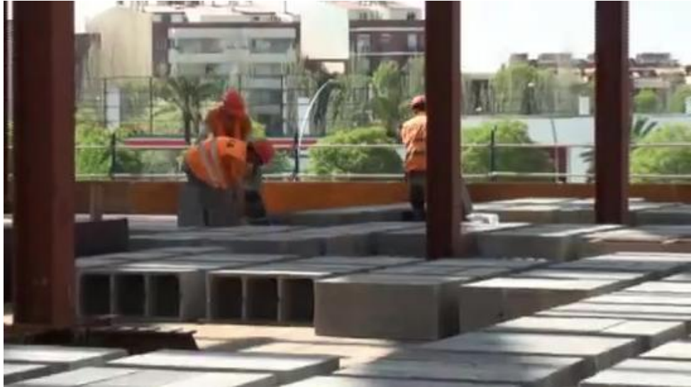
Imagen 3. Colocación de elementos aligeradores
