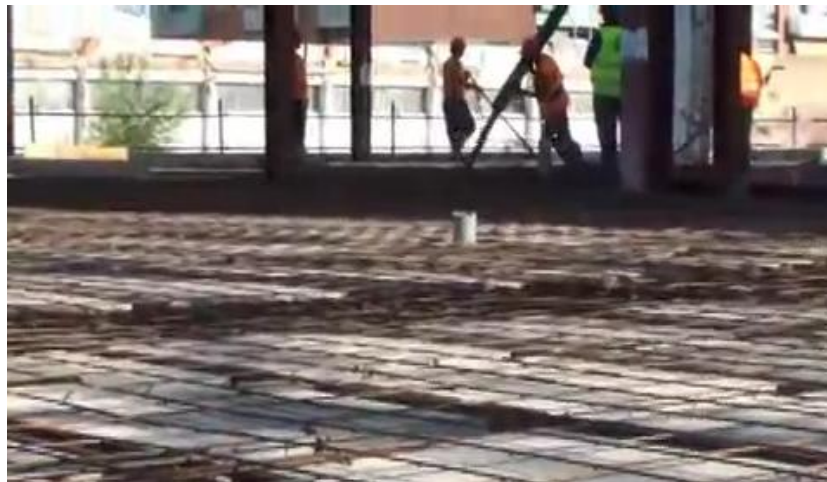
Imagen 5. Vertido del hormigón
