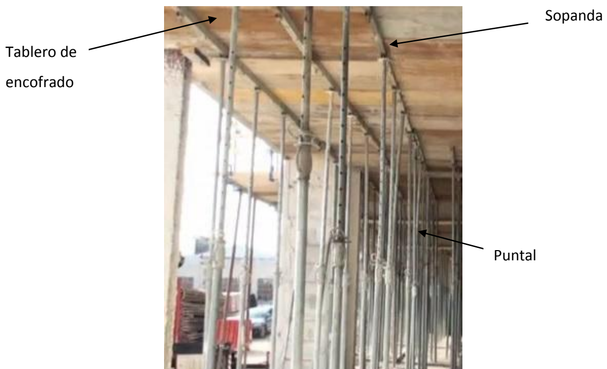
Imagen 2. Encofrado
