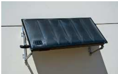
Imagen 50. Colocación colector solar TODO EN UNO
