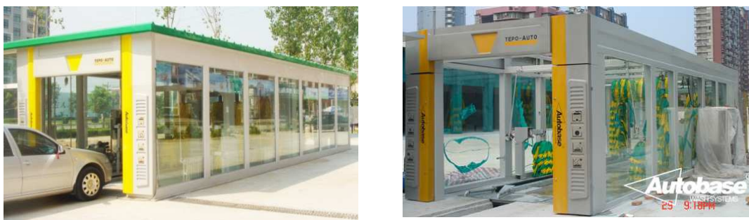
Imagen 17. Lavado mecánico (Túnel de lavado)
