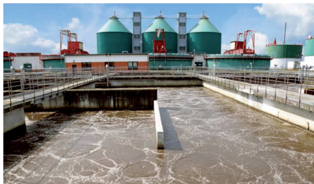
Imagen 9. Estación de depuración de aguas residuales
