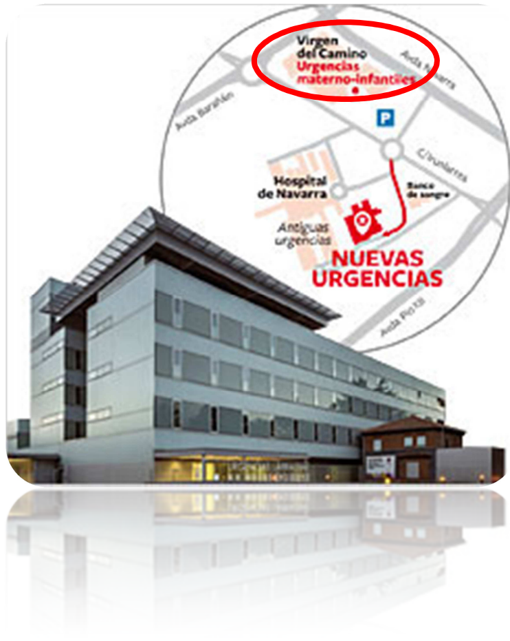
Figura 1. Edificio de Urgencias Virgen del Camino del Complejo Hospitalario de Navarra
