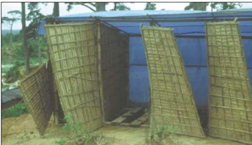
IMAGEN 13: IMAGEN DE UNA LETRINA DE ZANJA (BANGLADESH)
