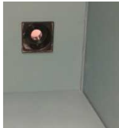
IMAGEN 74 Y 75: AGUJERO PARA CHIMENEA DE VENTILACIÓN
