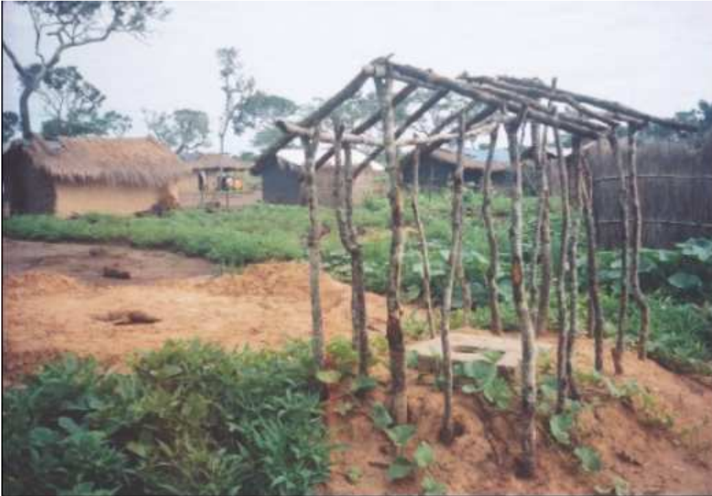
IMAGEN 16: IMAGEN DE LA FABRICACIÓN DE UNA LETRINA FAMILIAR
