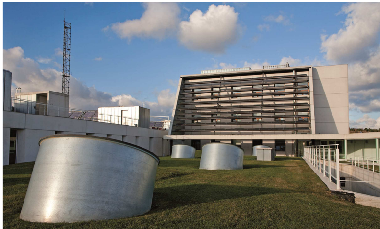
Fig MP9: Imagen presente en el panel de inicio del programa (Edificio de CENER, Sarriguren).
