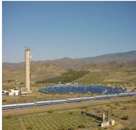
Figura 17. Torre central de distribución Norte [17]
