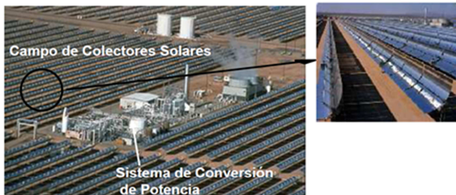
Vista general de una central termosolar con CCPs.
