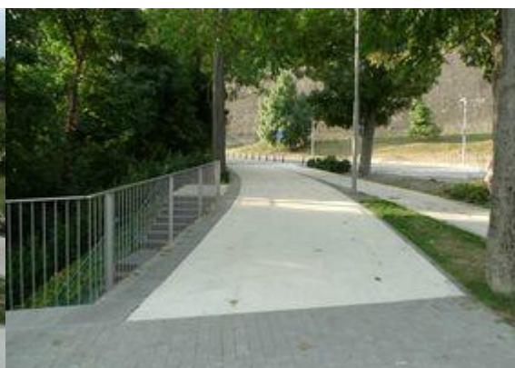
Imagen PT 29 236 (único tramo con pendiente longitudinal > 6 %).
