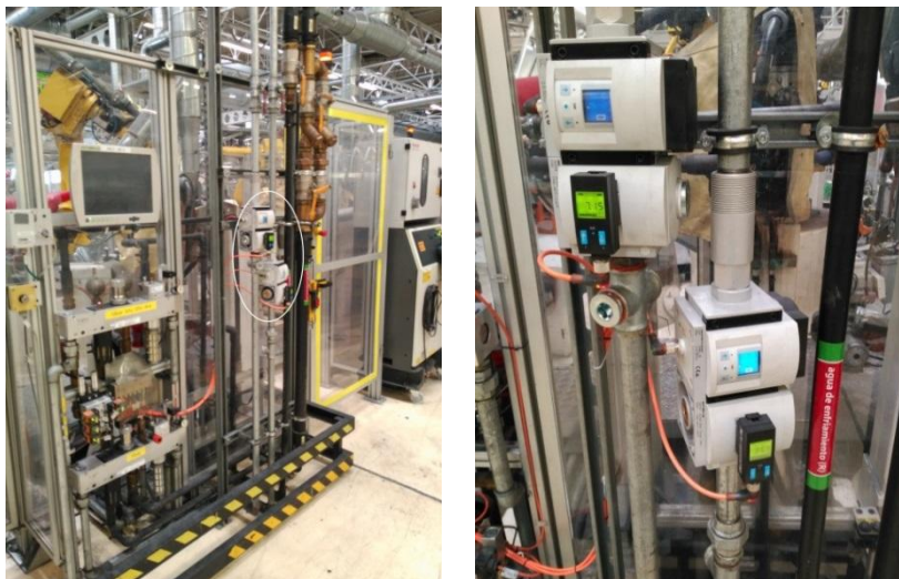
Ilustración 4.5 - Panel HIP y contadores de 6 y 12 bares
