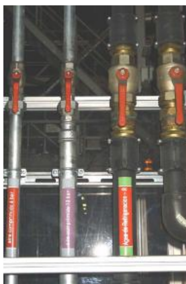
Ilustración 4.3 - Redes de distribución agua y aire en VW Navarra
