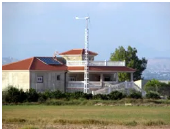
Figura 14. Instalación híbrida de placas fotovoltaicas y aerogenerador.
