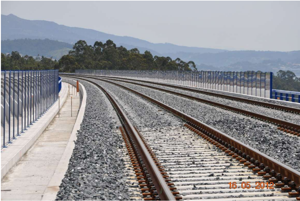
Imagen 10: Pantalla acústica en vía férrea.
