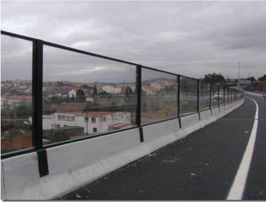
Imagen 9: Pantalla acústica en carretera.
