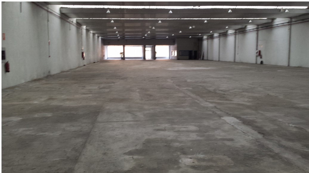
Figura 1.1 Estado actual de la nave.
