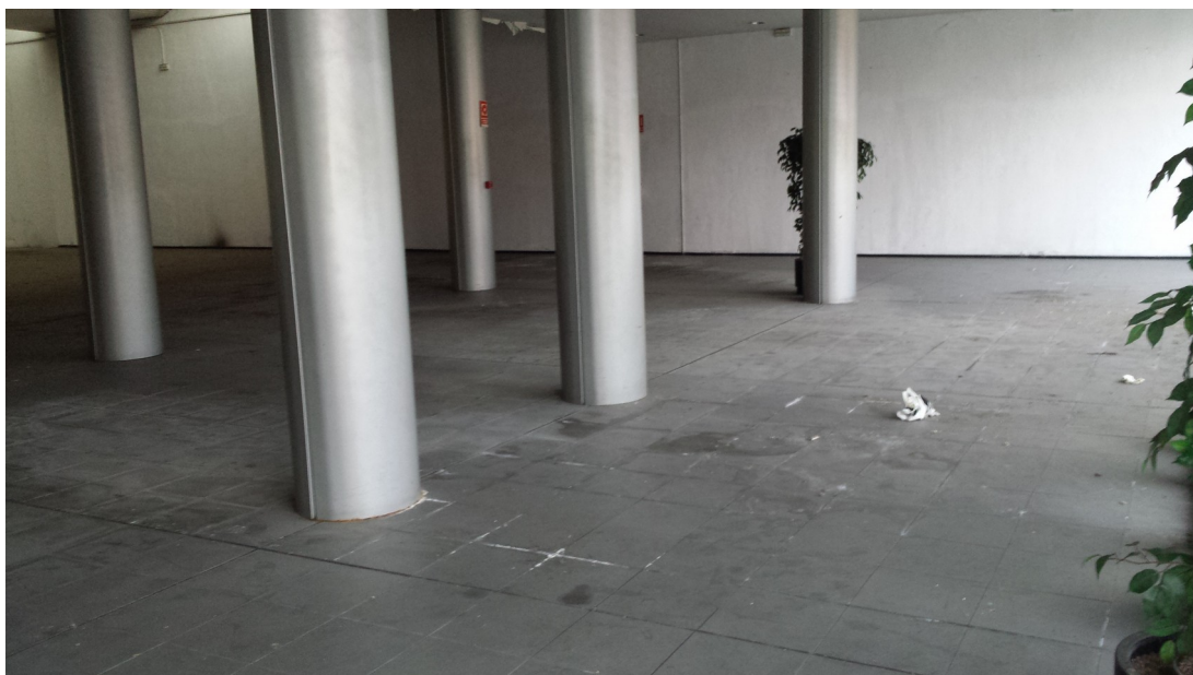
Figura 1.2 Detalle estado actual zona 2
