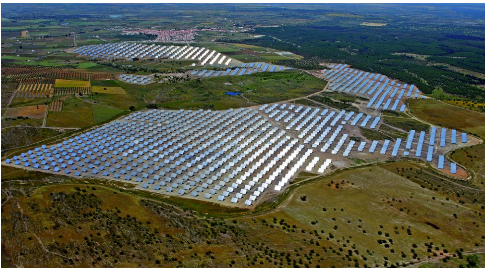
Figura 3.1: Vista aérea de la planta fotovoltaica de Amareleja ( http://www.energia.eiffage.es ).
