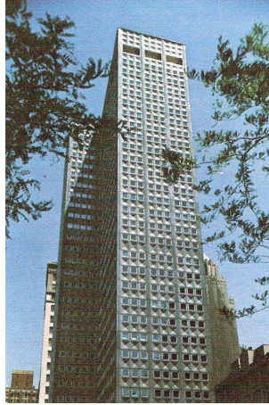
Figura 3.2: Edificio de la central de la empresa ALCOA en Pittsburgh
