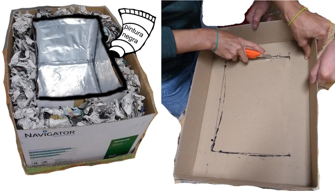
Ilustración 16. Marcar la tapa de la caja de DIN A3 y recortar. Fuente: Pablo Ausejo.
