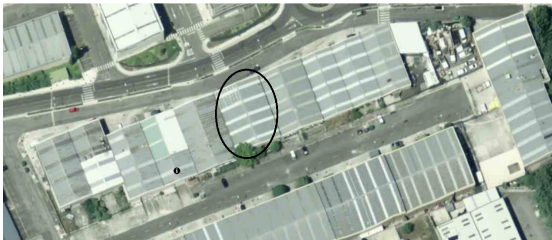
Vista aérea de la nave industrial.
