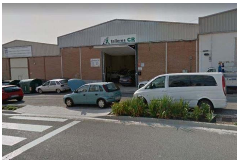
Vista frontal de la nave industrial.
