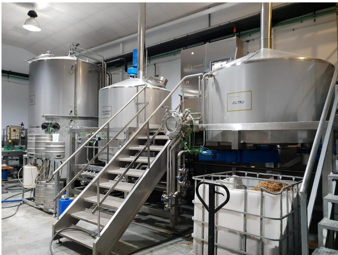
Figura 7. Instalación de minicervecería con tanque macerador-cocedero y filtro.
