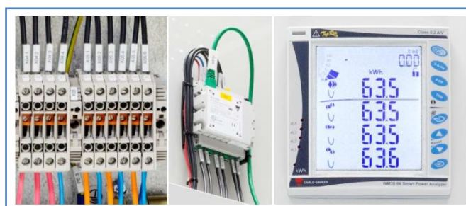
Ilustración 8. Analizador de potencia. Fuente: INGATEAM.
