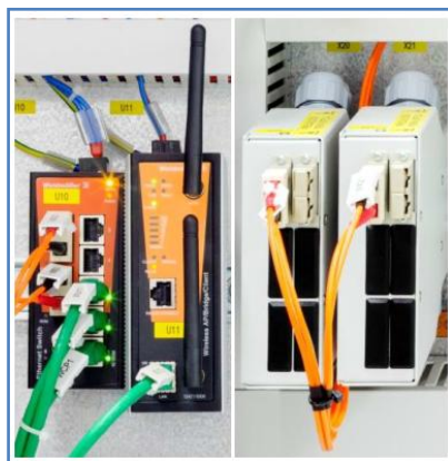
Ilustración 9. Adaptador Wi-Fi y switch . Fuente: INGETEAM.
