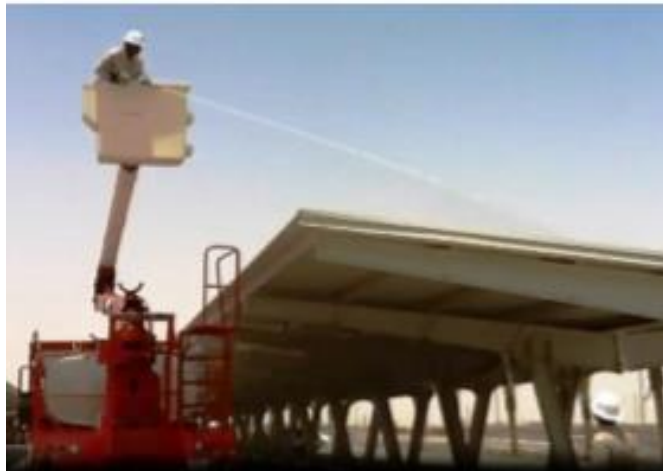
Figura 47. Proceso de limpieza manual mediante agua a presión
