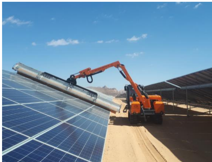
Figura 57. Limpieza de módulos mediante cepillo acoplado a tractor, fabricante BP Metalmeccanica
