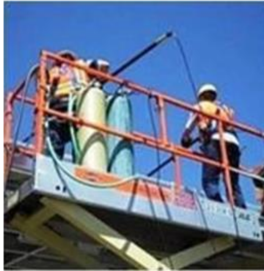
Figura 48. Proceso de limpieza manual mediante aire comprimido
