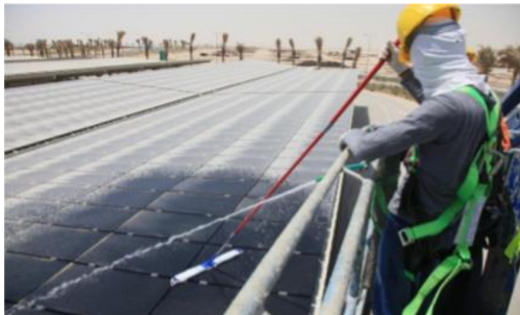
Figura 46. Proceso de limpieza manual con mopa y agua
