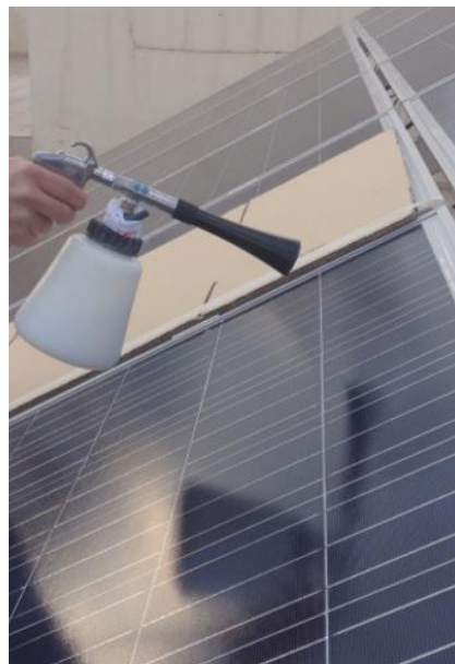
Figura 41. Aplicación del producto SurfaShield G mediante aerosol en módulos ya instalados
