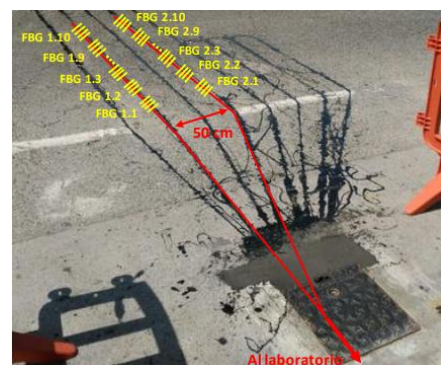
Figura 8: Fotografía de los sensores instalados sobre el asfalto[9].
