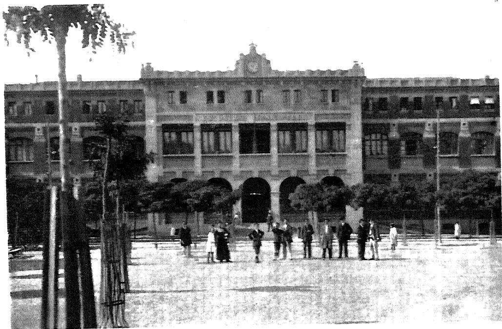
Moderno edificio cuya construcción responde á las más escrupulosas exigencias de la pedagogía, constituyendo el primer grupo escolar de la capital.
