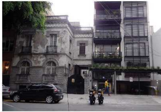
Edificios de inicios del siglo XX deteriorados junto a una torre de lofts recién construidos en la Colonia Roma de la Ciudad de México.
