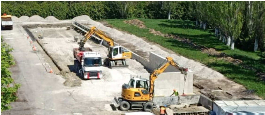
Figura 4: Construcción de la planta piloto de secado solar.
