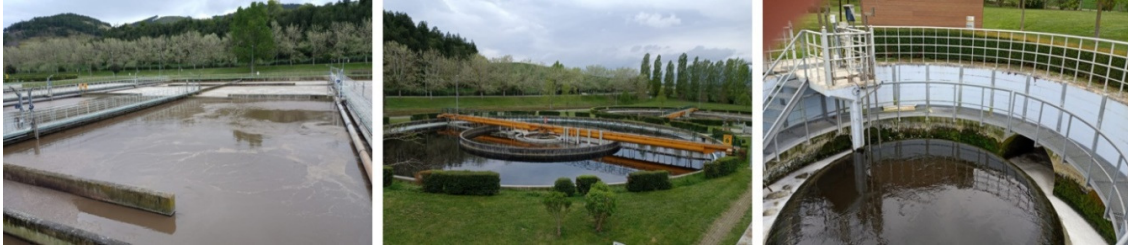
Figura 3: Proceso en las balsas de aireación. Proceso de decantación secundaria. Proceso de arqueta de salida.
