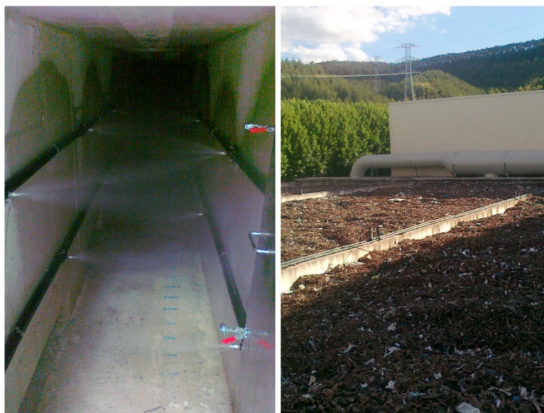
Figura 15: Galerías de humidificación de aire. Biofiltros. (Planta de compostaje de lodos de Arazuri. RETEMA)
