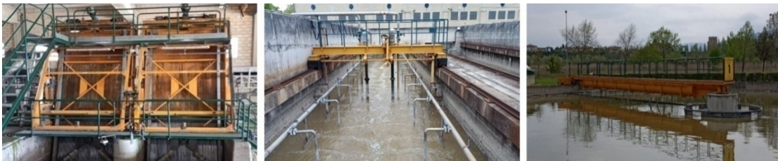
Figura 2: Proceso de rejillas finas. Proceso de desarenado y desengrasado. Proceso de decantación primaria.
