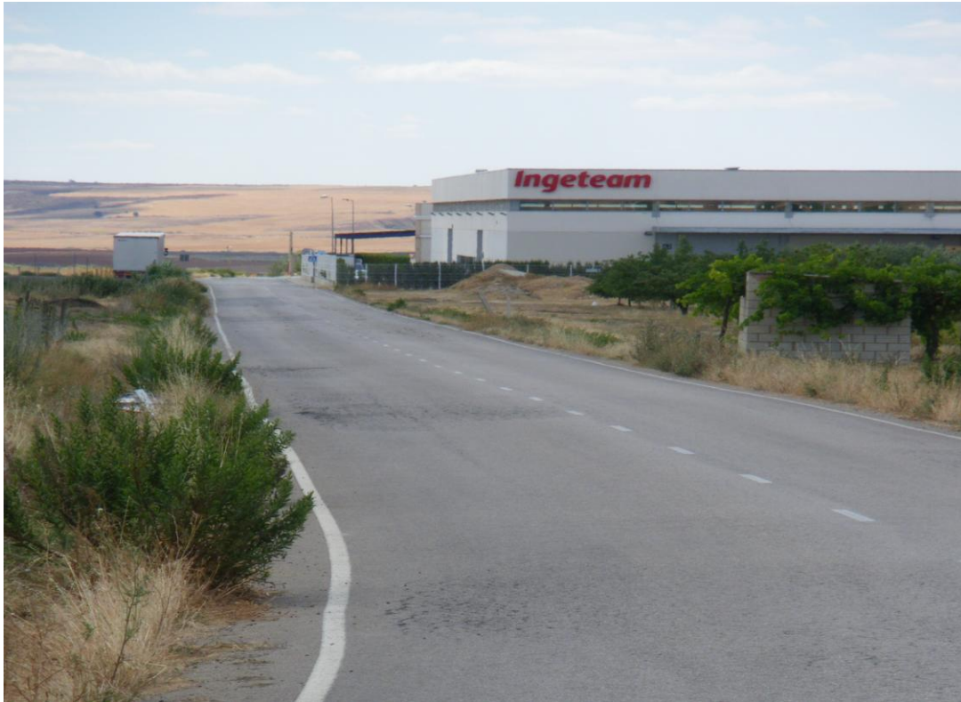
Acceso desde NA-129, zona noroeste
