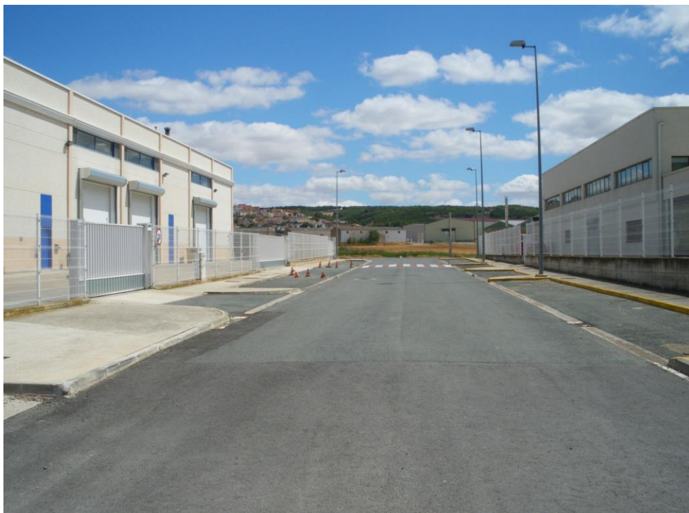
Viaro existente acceso polígono actual.
