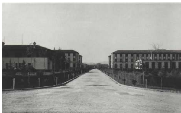
Pabellones del hospital provincial en 1943
