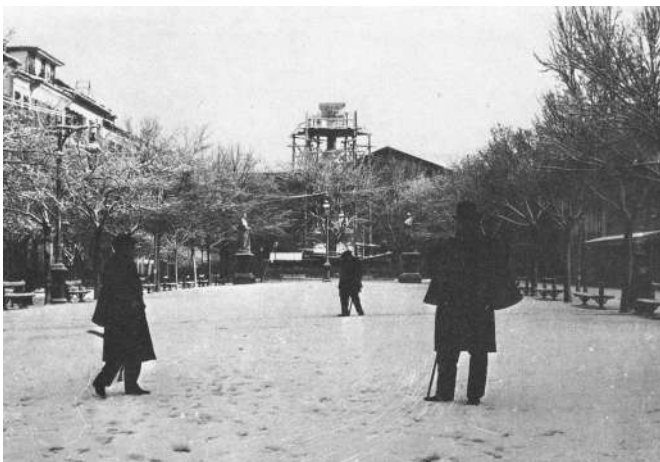
Construcción Monumento a los Fueros, Pamplona.
