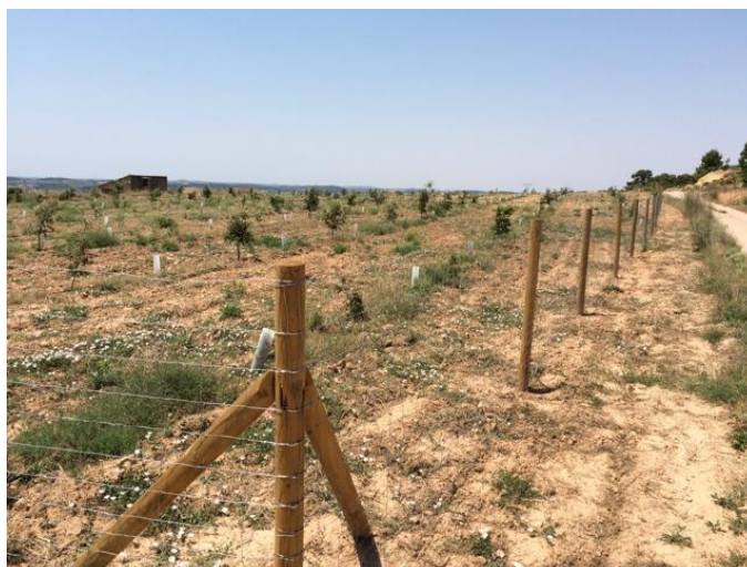
Figura 1: Diseño vallado con malla cinagética. Fuente: https://micofora.com/
