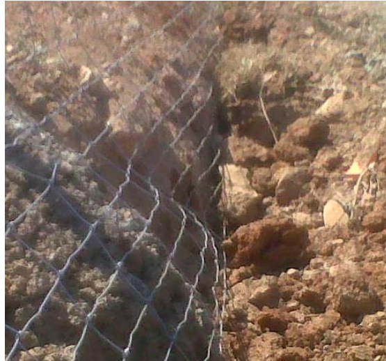
Figura 3: Enterramiento de la malla (Vinuesa vallas y cercados, 2013).
