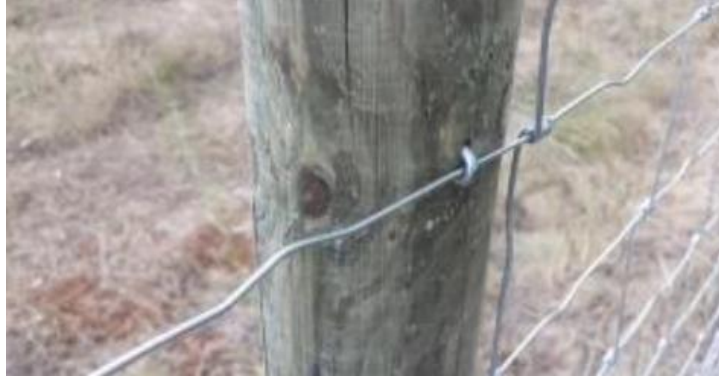
Figura 5: Detalle sujeción de alambres con grapas (Vinuesa vallas y cercados, 2013).
