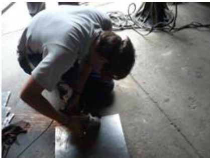
Corte de conos con rebarbadora.
