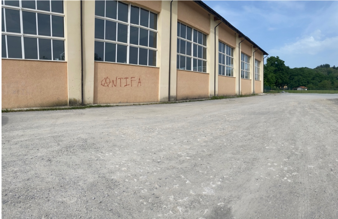
Figura 5: Espacio ubicado en la parte trasera del polideportivo.
