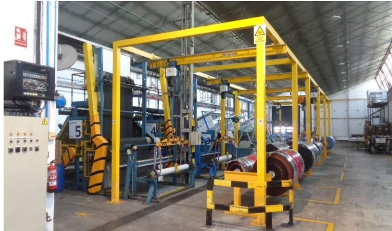
Ilustración 44. Vista general de la sección de verificación.
