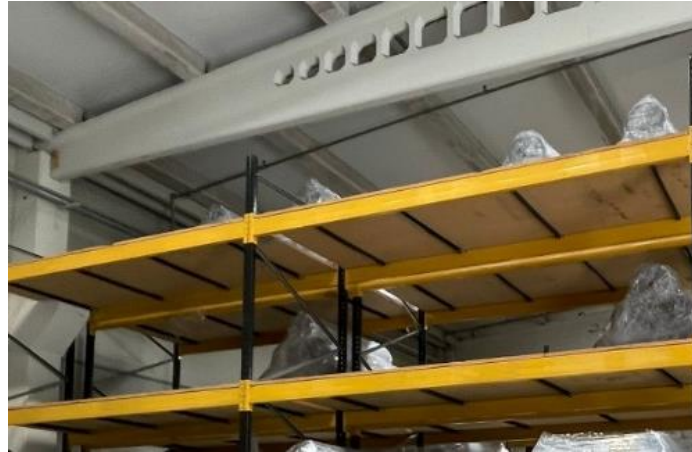
Ilustración 149. Cercha del almacén
