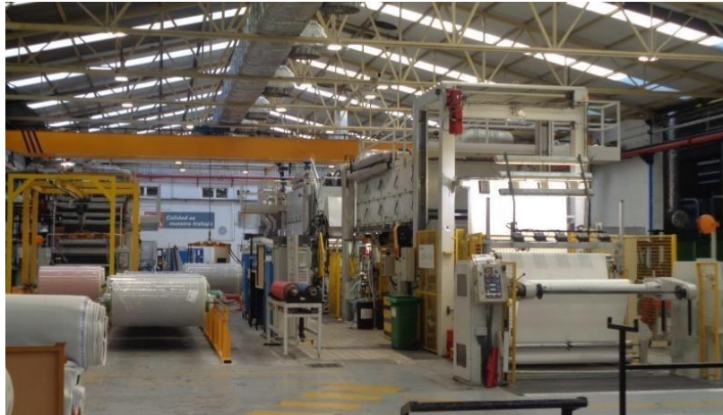
Ilustración 41. Máquina GI2 y bobinas almacenadas.
