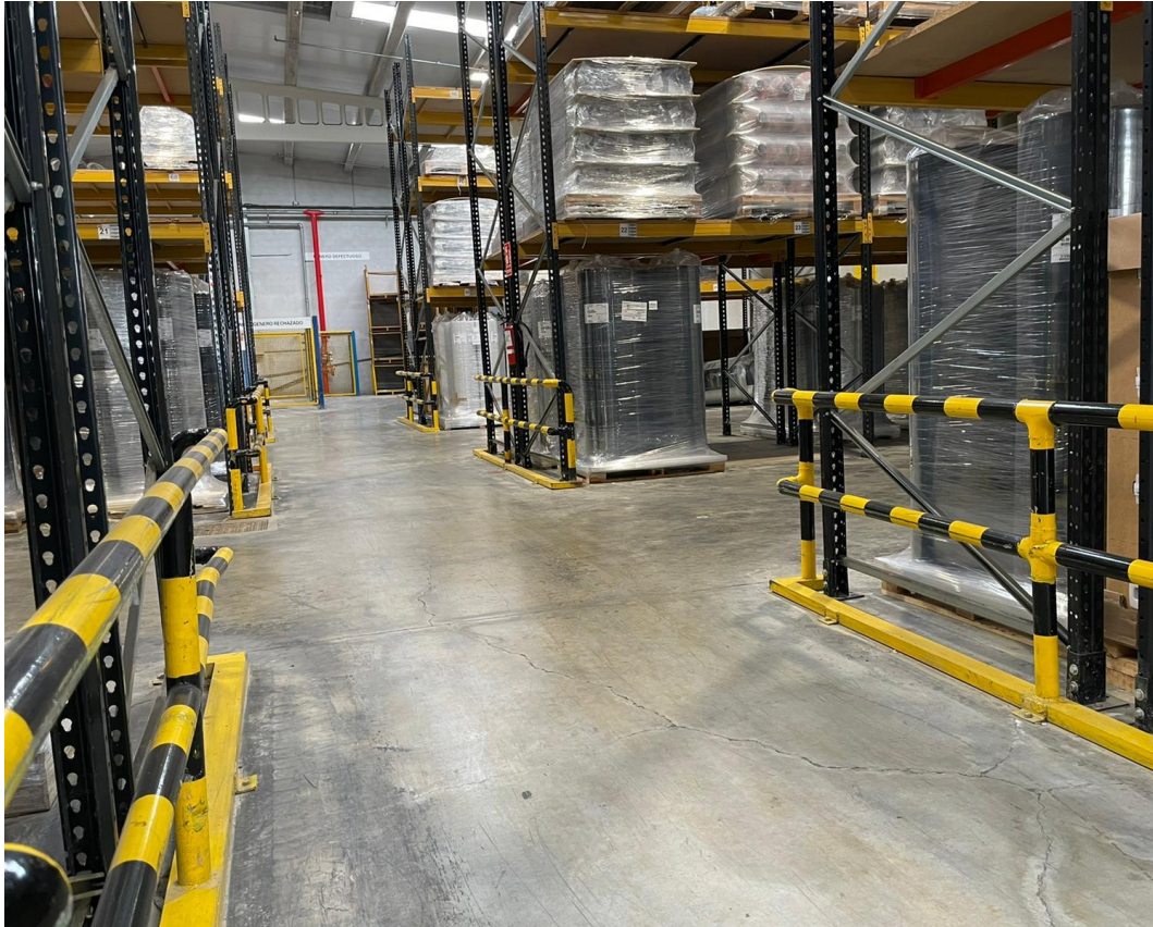
Ilustración 70. Estanterías protegidas con protecciones según normativa
