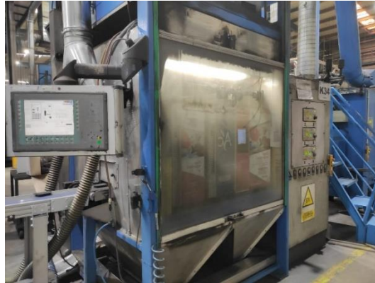
Ilustración 26.Zona de pintura. Fuente: Elaboración propia
