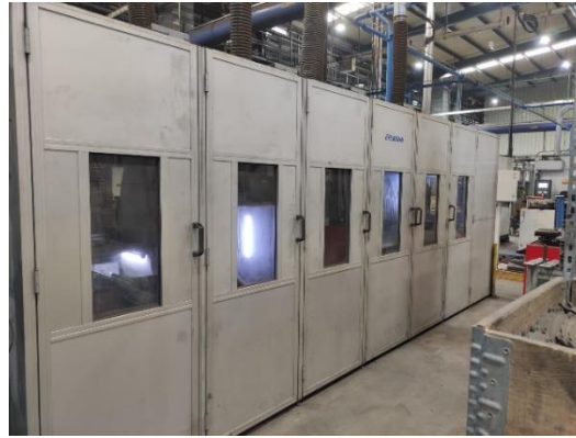
Ilustración 23. Área de mecanizado. Fuente: Elaboración propia
