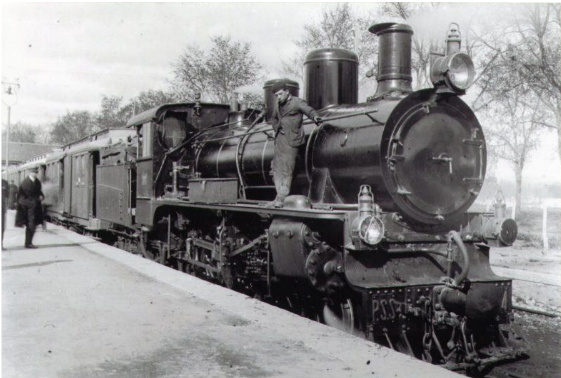
Figura 6: Ejemplo de máquina de vapor en España, tren del Plazaola en la estación de Pamplona (1920) [8] .
