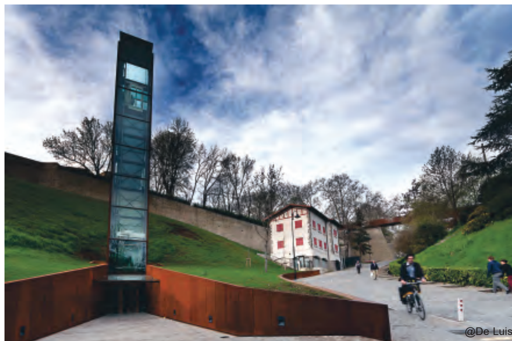
Elevador urbano da Meia Lua e passarela de pedestres
