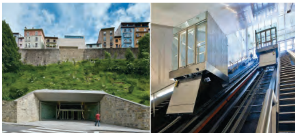
Elevadores urbanos Rochapea-Calle Descalzos @Cutillas
