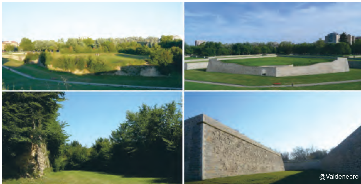
Revelim e contraguarda de Santa Clara, antes e depois das obras de restauração
