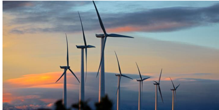
Figura 1. Aerogeneradores de tres palas y eje horizontal
