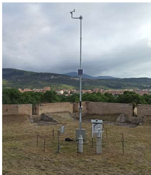
Figura 40 Equipos de la estación meteorológica [9]
