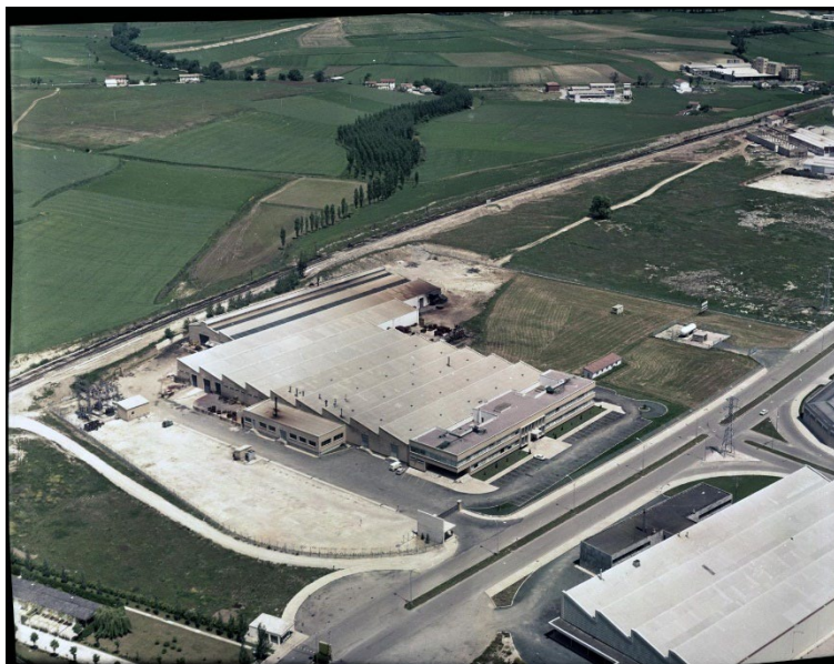
Iturria: Vista aérea de las instalaciones industriales de Eaton Ibérica en el polígono de Landaben en Pamplona. (1972). Nafarroako Artxibo Orokorraren Fototeka. ES/NA/AGN/F432/FOT_FOAT_3779.
