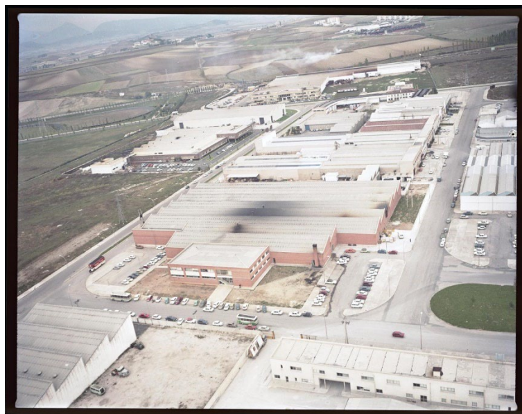
Iturria: Vista aérea de las instalaciones de Industrias Esteban en el polígono de Landaben en Pamplona. (1974). Nafarroako Artxibo Orokorraren Fototeka. ES/NA/AGN/F432/FOT_FOAT_3951
