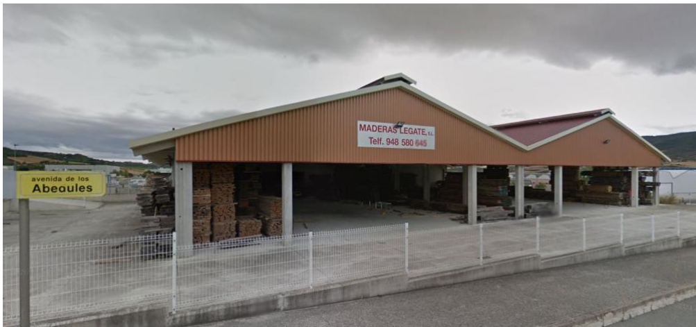
Ilustración 19: Estado Actual de la propiedad
