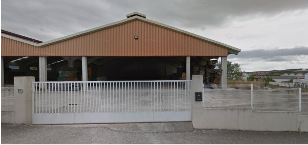
Ilustración 20: Estado Actual de la propiedad
