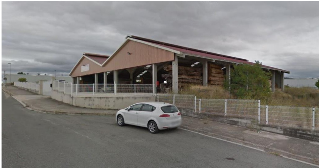
Ilustración 21: Estado Actual de la propiedad
