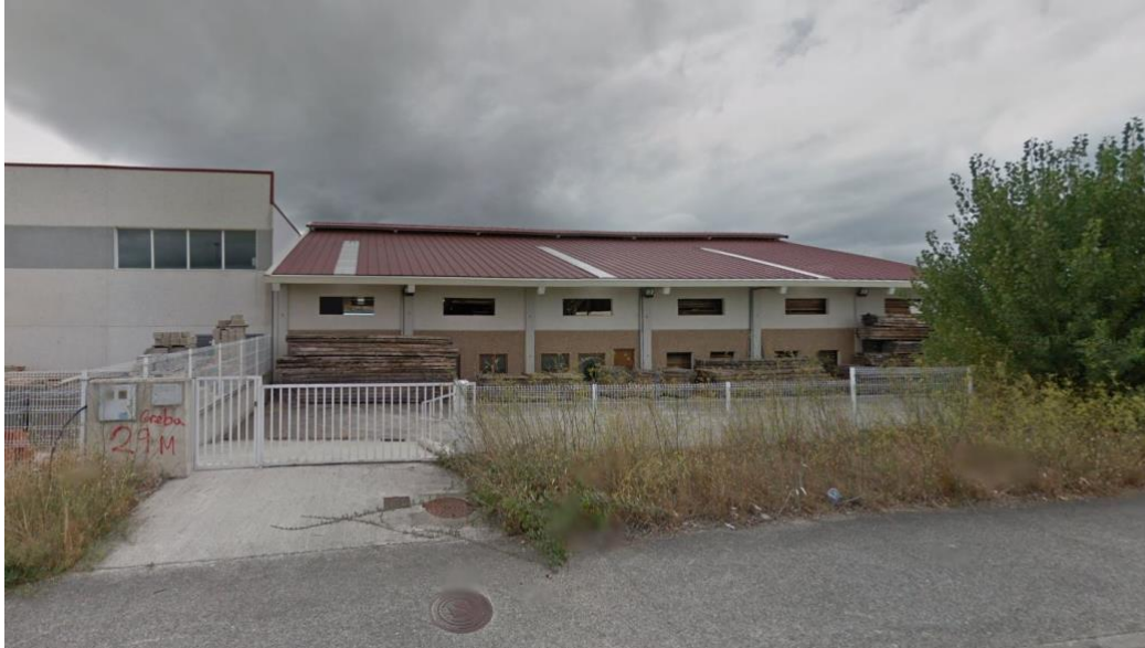
Ilustración 22: Estado Actual de la propiedad
