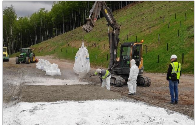
Fotografía 3. Dosificación de cementantes en zona de pruebas
