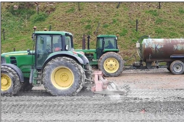
Fotografía 4. Mezclado de suelo y cementantes
