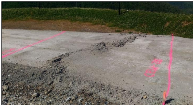
Fotografía 8. Aspecto de la zona de pruebas CEM-I-SR tras 40 días desde su estabilización
