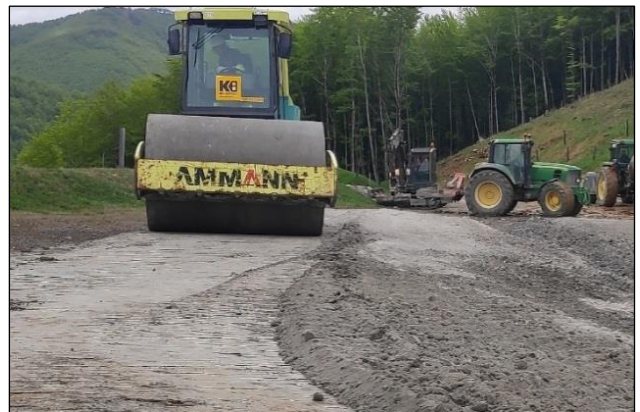
Fotografía 5. Compactación de zona de pruebas
