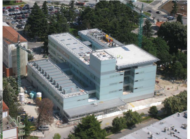
Figura 1.3: Foto aérea del edificio de Urgencias terminado.
