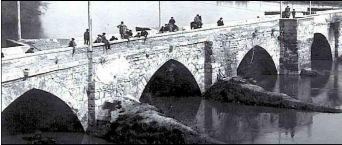
Detalle de los primeros arcos y machones del puente de Tudela, sin fechar 149 .
